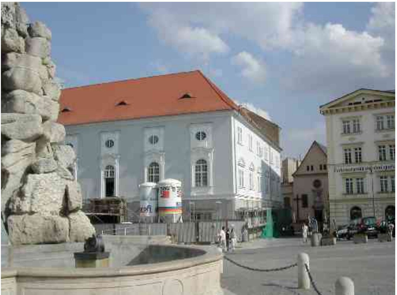
Die Redute: Es lässt sich jetzt schon erahnen, welche Bereicherung des Stadtbildes die renovierte „Redute“ sein wird.
